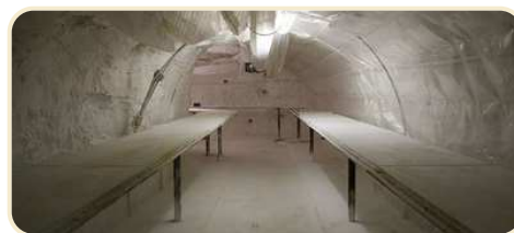
دیوار و سقف سفید قابل شست‌وشو
